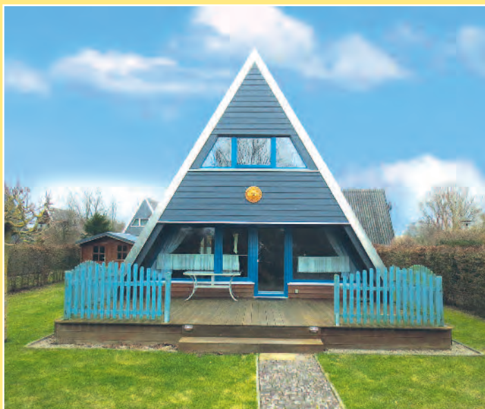
Ferienhaus im Ostseeresort Damp - Pos. 33
