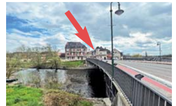
Blick auf das Objekt
