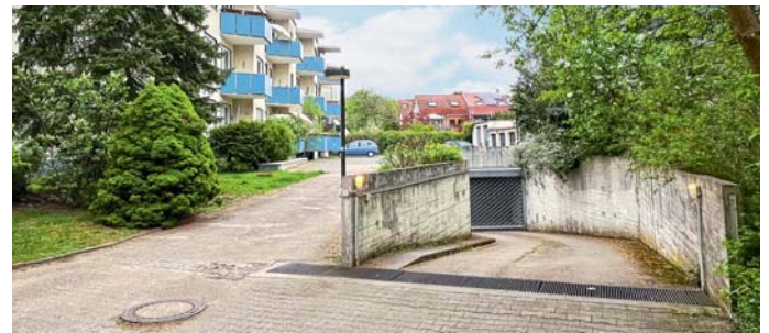
Tiefgarageneinfahrt im Innenhof
